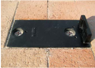
⑤ベースの取付完了。
