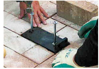
④Φ 10 測量釘を打ち込む。* 1
