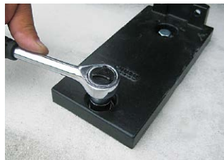
⑥レンチなどでベースをコンクリートに固定する。* 4
