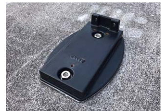
④硬化したら縁からはみ出した接着剤をカッターでカットしてください。* 6 (硬化までの間、本体固定用のネジ部の養生をお願いします。)
