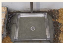
⑤受枠施工完了
