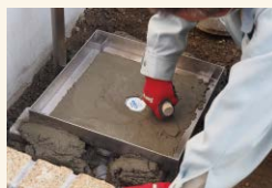
④モルタルで仕上げます。
