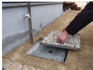
砂利を充填したまま脱着できる
