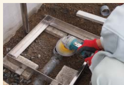
②排水管のレベルを調整します。
