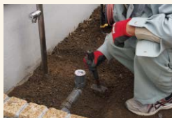
①地面を均します。
