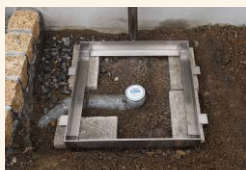
③受枠のレベルを調整します。
