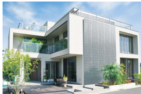
施工イメージ写真
