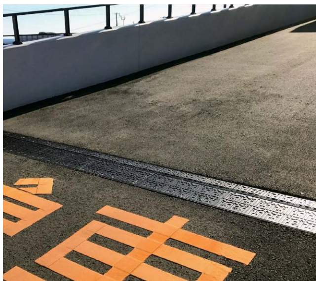
人工地盤用エキスパンションジョイントカバー（重荷重用）
