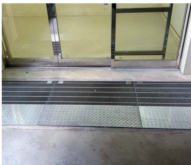
人工地盤用エキスパンションジョイントカバー（スチールグレーチング排水タイプ）
