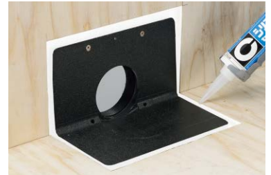
③木下地とルーフトレン本体の隙間をコーキングします。
