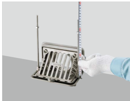
②融雪カバーの天端位置を考慮しナット高さを決める
