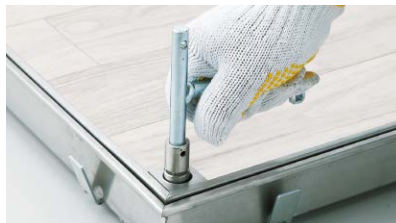
① 専用鍵ハンドルを用いて4隅のボルトを緩めます。
