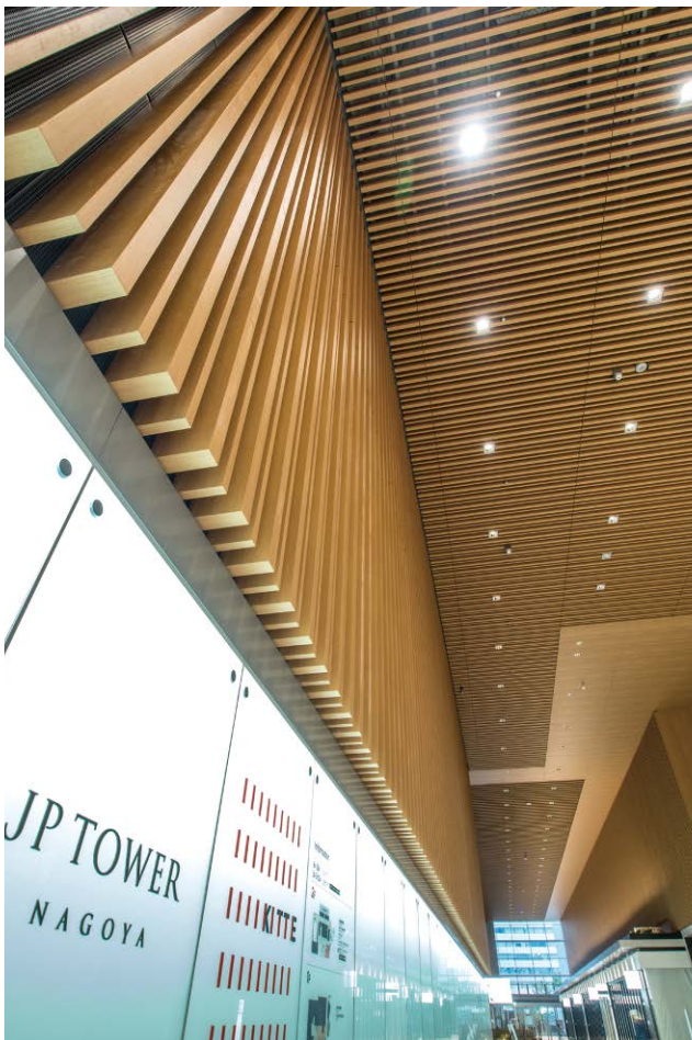
仕上：木目シート貼り 納入場所：JP TOWER 名古屋／名古屋市中村区
