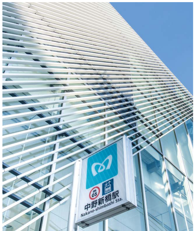
仕上：フッ素焼付塗装 東京メトロ中野新橋駅／東京都中野区
