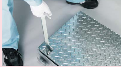
②ボルトボックス側面の穴に専用ハンドルを引っ掛けます。
