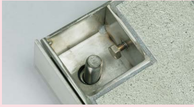
①キャップ、ナット、ワッシャー、ゴムワッシャー、スペーサーを取り外します。
