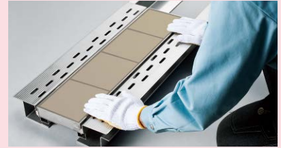
③蓋を上から押さえて受枠にセットします。 ⚠手を挟まないように注意してください。
