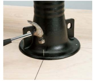
④防水継手本体を挿入しクギで固定。
