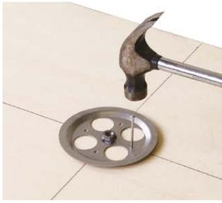
①型枠に墨出し後、位置決め座をクギ(別途)で固定します。
