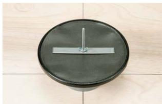
④上部に保護カバー・押え板・蝶ナットの順に入れて打込み本体を蝶ナットで確実に固定してください。
