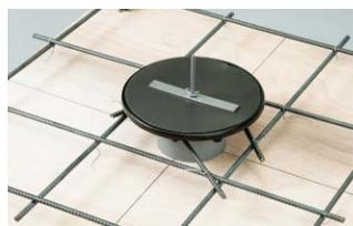
⑤打込み本体が型枠に確実に固定されている事を確認し、配筋にアンカー部を固定してください。
