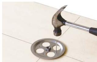
①型枠に墨出し後、位置決め座をクギ(別途)で固定します。
