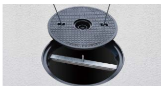
⑤マンホールハンドル A2 を使用し蓋を持ち上げ移動します。
