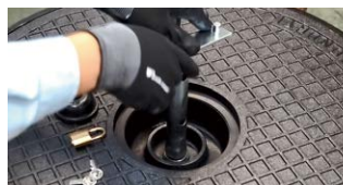
④小蓋用開閉ハンドルにてナットを緩めナット・ワッシャ・パッキンを取り除きます。
