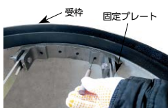
①マンホール内壁に固定プレートを当てアンカー位置をケガйтеしてください。
