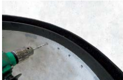
②ケガキに合わせてドリルで下穴を開けてください。下穴径8.5mm 深さ45mm 穴加工後内部の削り屑を取り除いてください。
