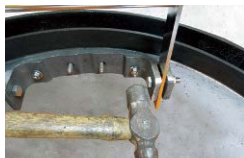
④ハンマーで芯棒を打ち込んでください。スリーブ部が開き、下穴の壁面に食い込み固定されます。
