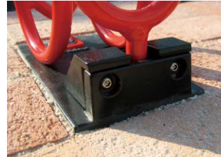
⑦専用レンチを使用してベースにベースカバーを取り付ける。
