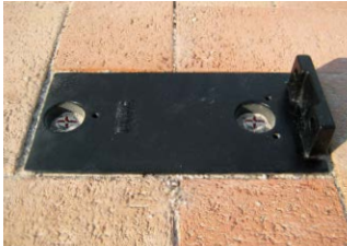
⑤ベースの取付完了。
