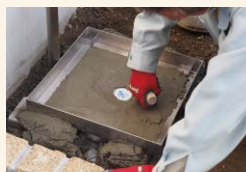
④モルタルで仕上げます。
