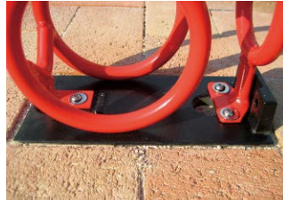
⑥専用レンチを使用してベースに本体を取り付ける。
