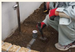
①地面を均します。
