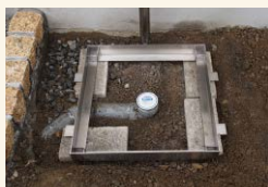
③受枠のレベルを調整します。
