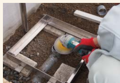
②排水管のレベルを調整します。
