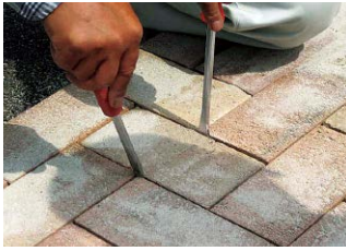
①ベースを取り付ける位置のインターロッキングブロックを抜き取る。
