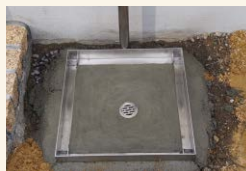
⑤受枠施工完了
