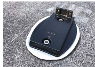
③ベースの上からしっかり押さえつけながら貼り付けます。(事前に接着する面のゴミや汚れなどは取り除き、十分乾燥させておいてください。)
