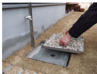
砂利を充填したまま脱着できる
