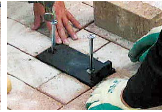
④Φ 10 測量釘を打ち込む。* 1
