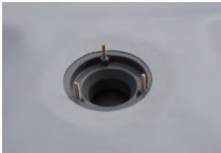
②防水施工 工事完了
