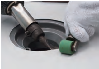
①熱風機でドレン本体と塩ビシートを加熱し、ローラー小手でドレン本体と塩ビシートをしっかりと融着させます。
