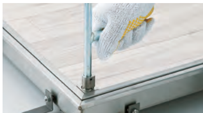
①専用鍵ハンドルを用いて4隅のボルトを取出します。
