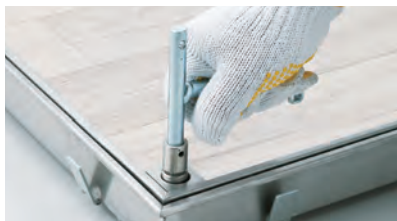
①専用鍵ハンドルを用いて4隅のボルトを緩めます。
