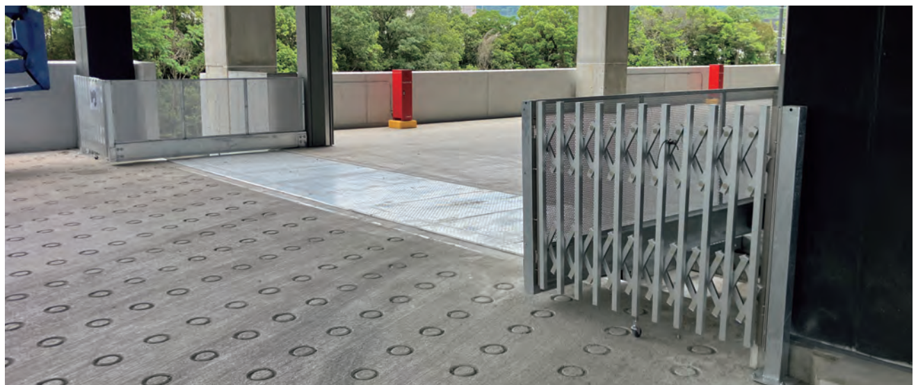
車両用エキスパンションジョイントカバー（スチールCHPLタイプ）
