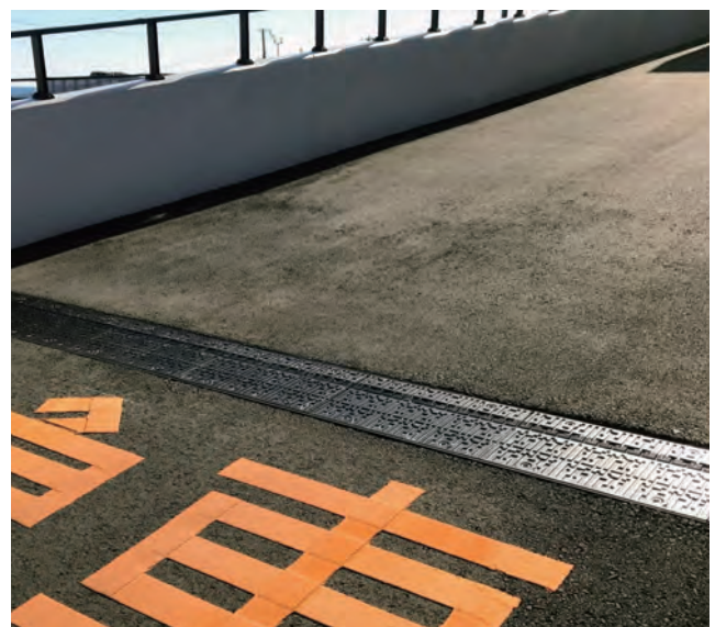
車両用エキスパンションジョイントカバー（重荷重用）
