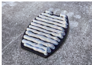
①接着用プレートに接着剤を塗布します。※ 5
