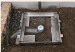
③受枠のレベルを調整します。
