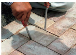
①ベースを取り付ける位置のインターロッキングブロックを抜き取る。
