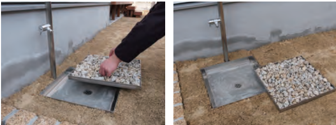
砂利を充填したまま脱着できる
