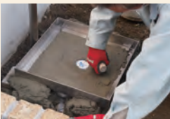
④モルタルで仕上げます。
