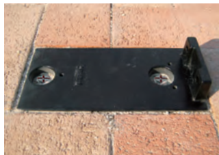
⑤ベースの取付完了。
