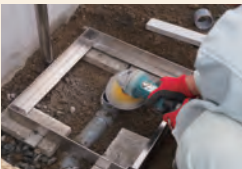
②排水管のレベルを調整します。
