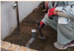
①地面を均します。
