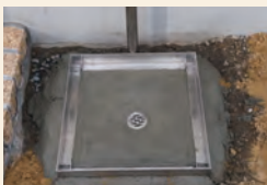
⑤受枠施工完了
