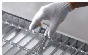
①グレーチングの連結部にRKを挿入する
