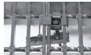
②RKをクロスバーとベアリングバーに引掛ける
