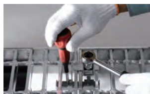
③RKが回転しない様にドライバー等で押えながらボルトを締め付ける
