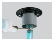
③下部からの排水ホース固定方法。仮設排水用金具とホースを番線・金具等でしっかり固定する。
