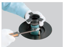
②上部からの排水ホース固定方法。仮設排水用金具とホースを番線・金具等でしっかり固定する。
