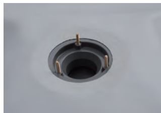
②防水施工 工事完了
