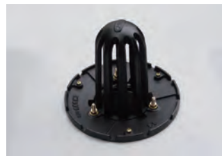
③防水層押えとストレーナをセットして完了
