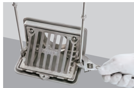
①防水層押えに付属のスタットボルトとナットを取り付ける
