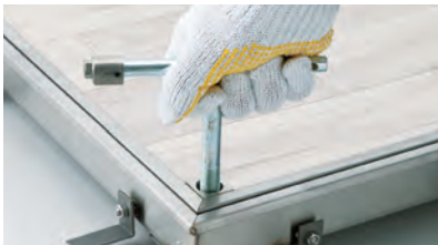
②専用鍵ハンドルのネジ部をボルト穴にねじ込みます。(対角の2箇所)
