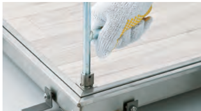
①専用鍵ハンドルを用いて4隅のボルトを取外します。
