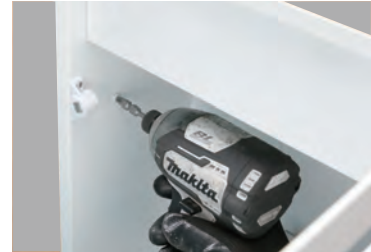
① 4箇所取付ビスで固定します。
