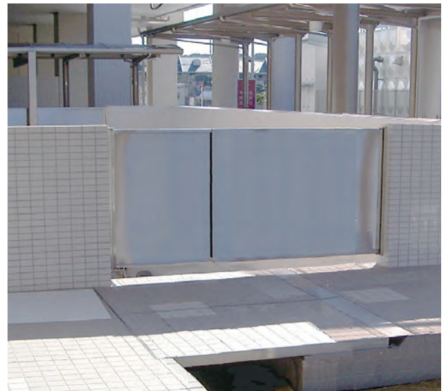
免震構造建築物対応型手摺
