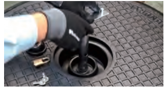
④小蓋用開閉ハンドルにてナットを緩めナット・ワッシャ・パッキンを取り除きます。
