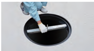
⑥固定バーを反時計回りに回転させ外します。
