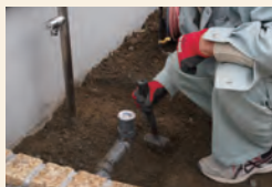
①地面を均します。
