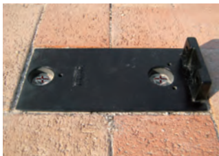
⑤ベースの取付完了。
