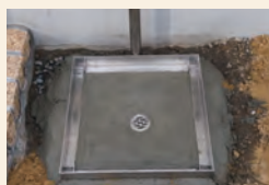
⑤受枠施工完了
