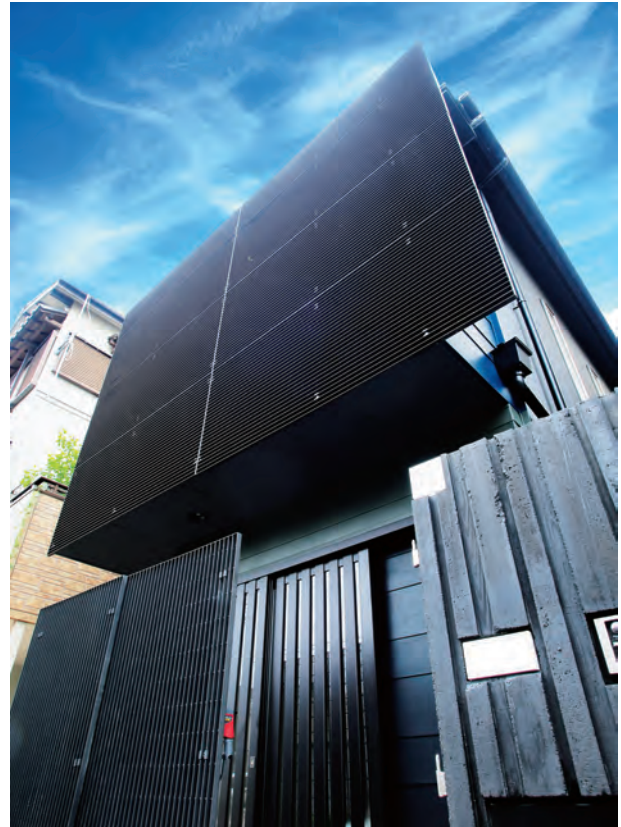
建物の外観にリン酸処理グレーチングが採用されました。
