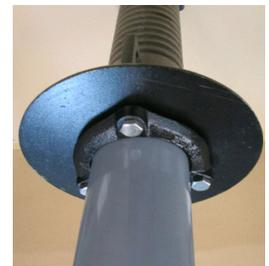
注意事項：パッキンのテーパ部は必ずフランジ側に接続し締付けて下さい。
